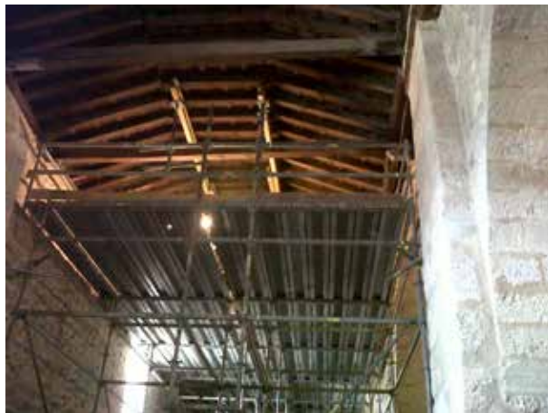
Foto 21.- Andamiaje para arreglo de artesanado (septiembre 2013) y arreglo cubierta sur (noviembre 2013).
