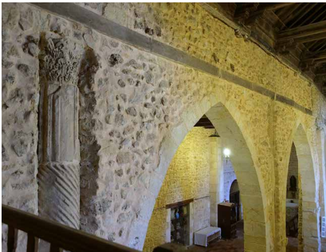
Interior de la Iglesia de la Sey
