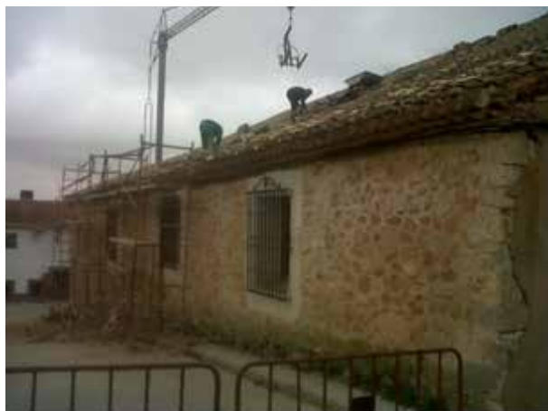
Foto 21.- Andamiaje para arreglo de artesanado (septiembre 2013) y arreglo cubierta sur (noviembre 2013).
